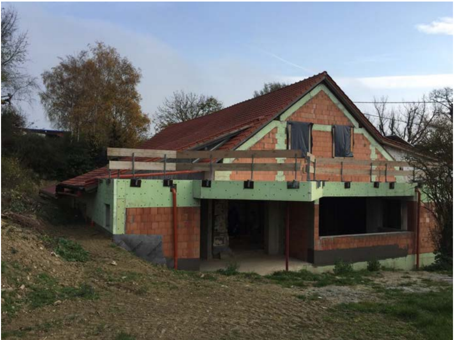
Der neue Halleneingang nimmt Gestalt an
